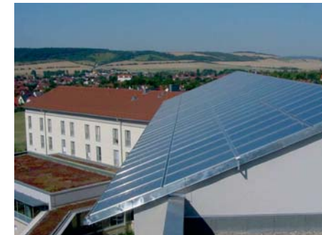
Solkollektor zur Warmwassererzeugung
