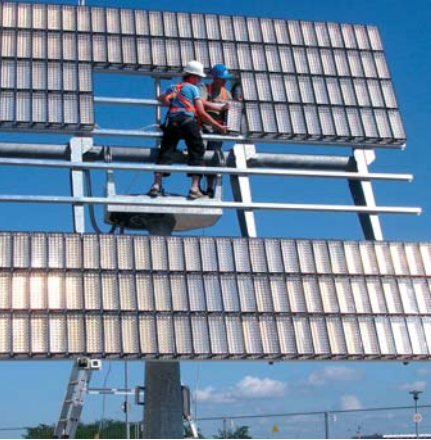
Montage von Konzentratormodulen, Quelle: Concentrix Solar GmbH
