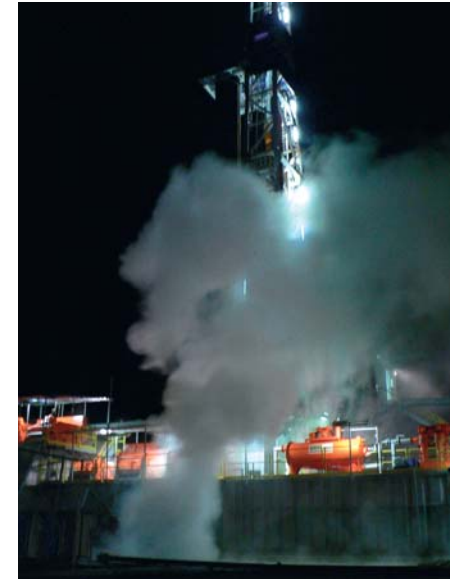
Geothermiebohrung Landau, Quelle: BESTEC GmbH
