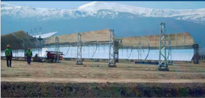
Abb. 6: Kraftwerk Andasol I in der Bauphase (im Hintergrund die Sierra Nevada)
