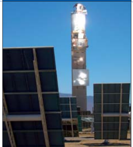
Abb. 4: Jeder Spiegel "zielt" auf den Receiver des Turms (Almeria)
